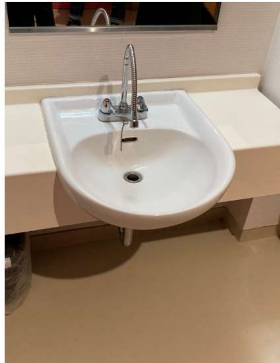
洗面台は通常よりも低い位置に設置。また、拘縮等の状況にあわせてどの角度からでも使用できるようになっている。
