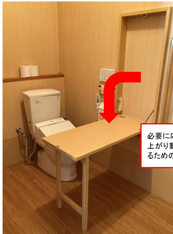
図表18 トイレに設置された可動式の補助台
