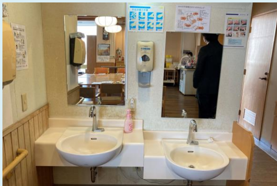
車椅子での利用や手洗い・顔洗い等の用途に応じて、高さの異なる洗面台を設置。
