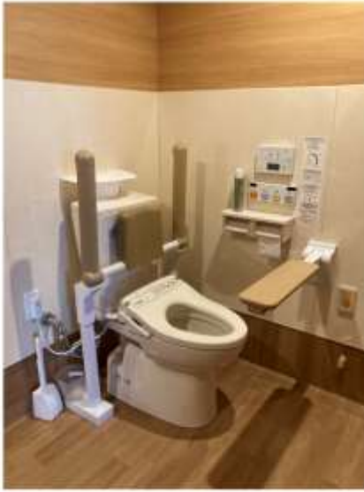
入所者自身の力を使って腰の上げ下ろしがしやすいよう、前傾姿勢が取れるような位置に手すりや台を設置するようにしている。
