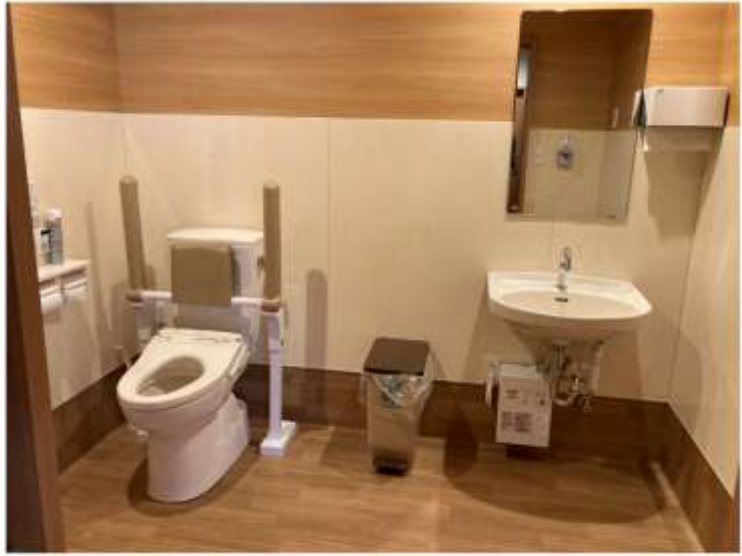
入所者自身の力を使って腰の上げ下ろしがしやすいよう、前傾姿勢が取れるような位置に手すりや台を設置するようにしている。
