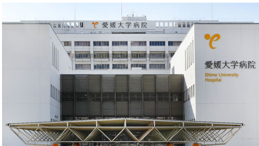
愛媛大学医学部附属病院外観
