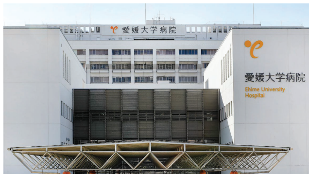
愛媛大学医学部附属病院外観
