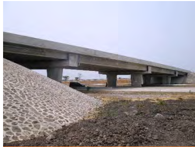
Jalan Tol Gempol Pasuruan 2013
