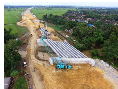
Jalan Tol Solo Kertosono 2015
