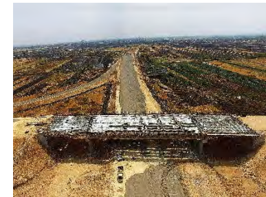
Jalan Tol Pejagan Pemalang 2014
