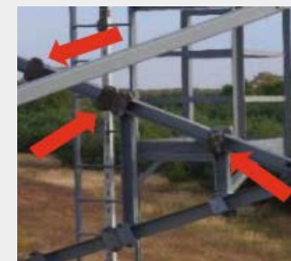
3. Kép: Drónos felvételek a telepített berendezésekről
