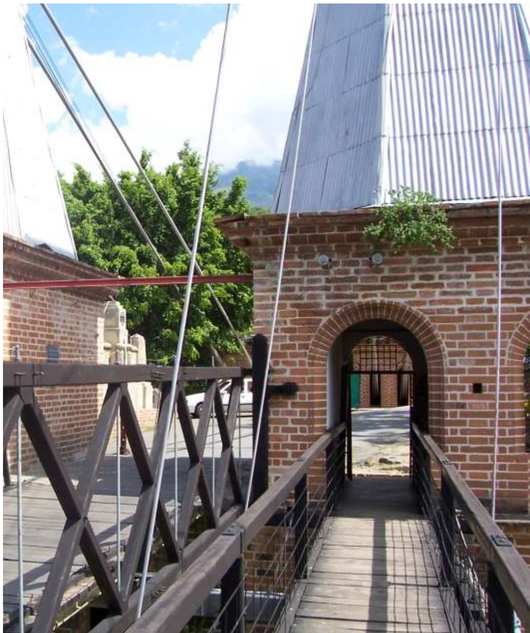
Foto: David Cárdenas PwC Colombia
